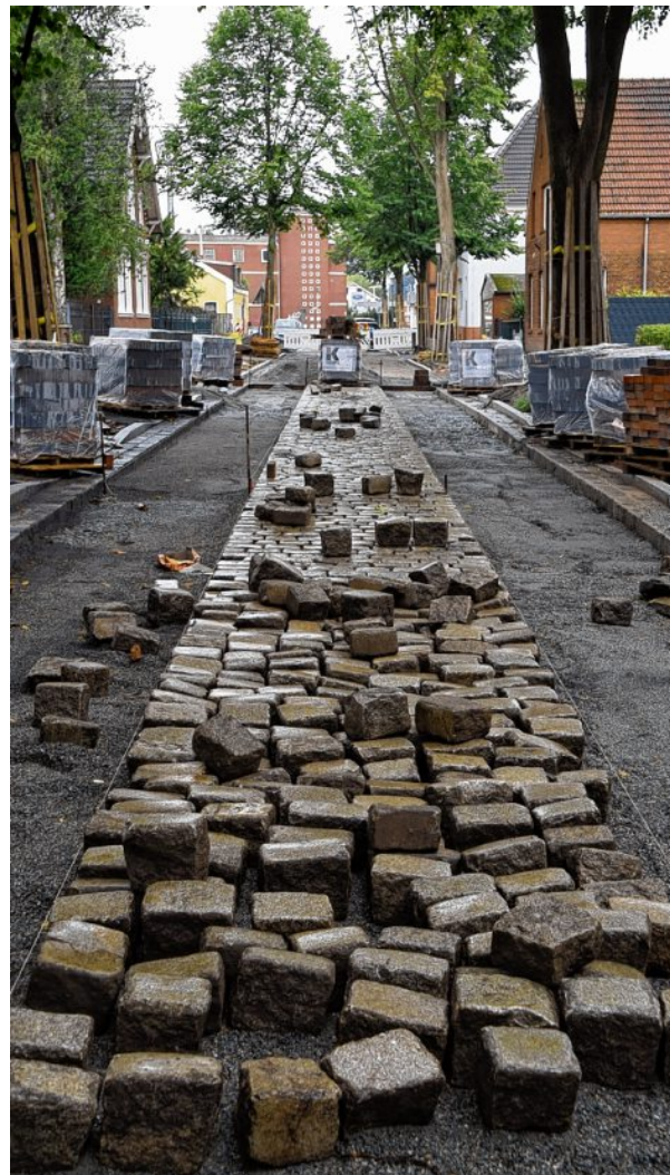
Die Pflastersteine werden neu verlegt.
