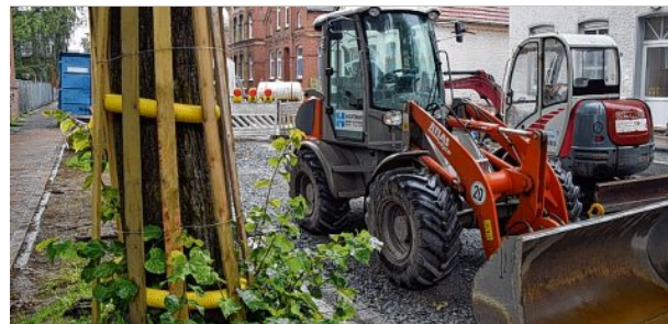
Die Linden in der Ulrichstraße sind geschützt.
