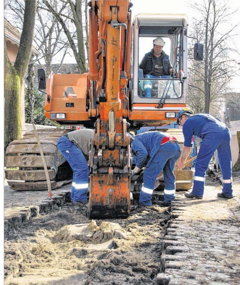
Mitarbeiter der Baufirma Schmidt graben in der Mitte der Fahrbahn ein Loch, um die darunter liegende Kanalisation zu erneuern. BILDER: BEHRENDT
