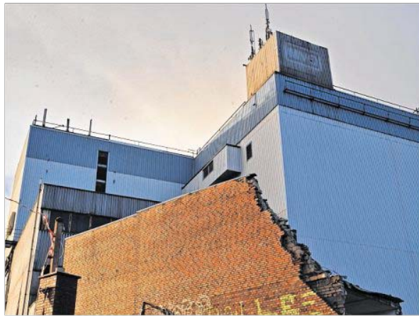
Auf dem Dach des Kühlturms befinden sich zwei Mobilfunkantennen von Vodafone und Telefonica (O2).
