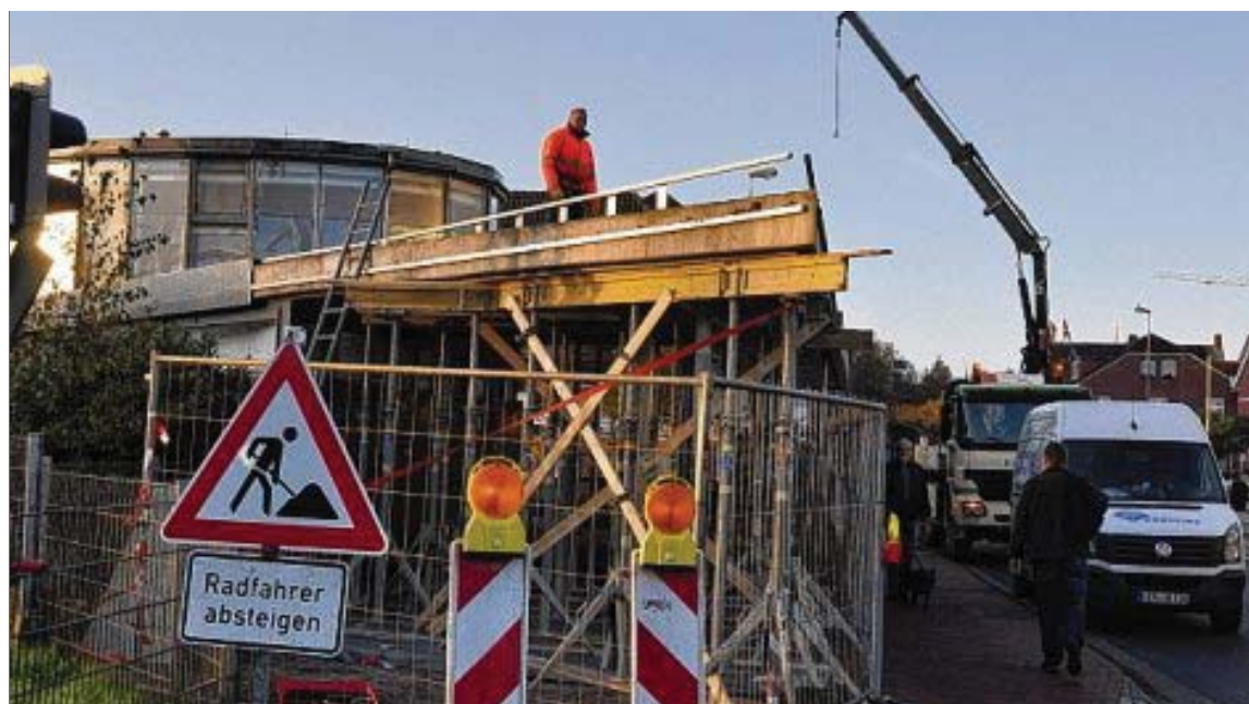
Der Pavillon ist derzeit komplett umzäunt.
