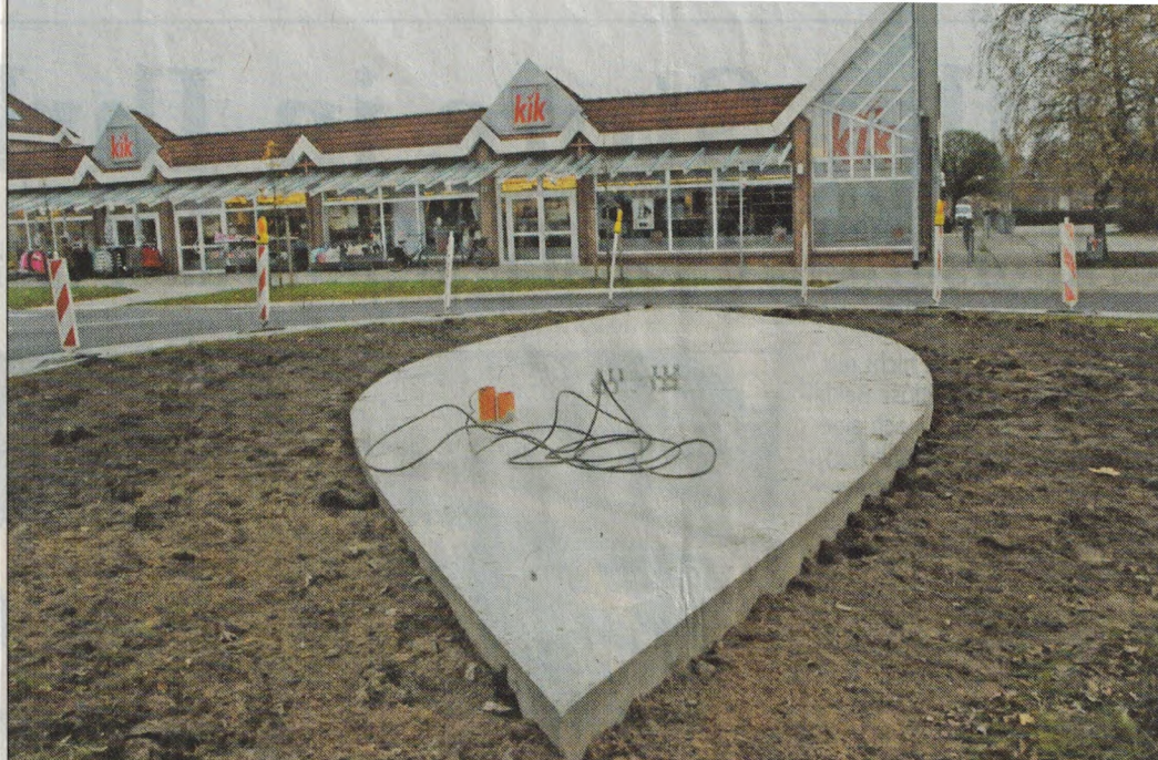
Die Betonplattform dient als Fundament für das Segel und ist einem Schiffsrumpf nachempfunden.
