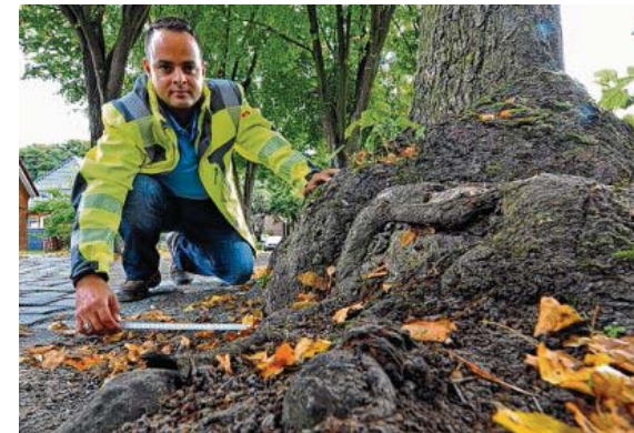
Uwe Felgenträger von den Stadtwerken vor den Wurzelaufläufern einer Linde.
