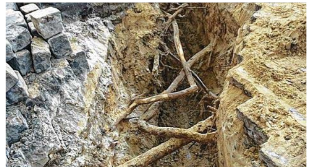
Beim Ausbuddeln der Kanalschächte stießen die Mitarbeiter auf allerhand dicke Baumwurzeln.
