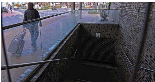
Der Tunnel-Zugang ist durch ein Rolltor versperrt. BILD: ARCHIV
