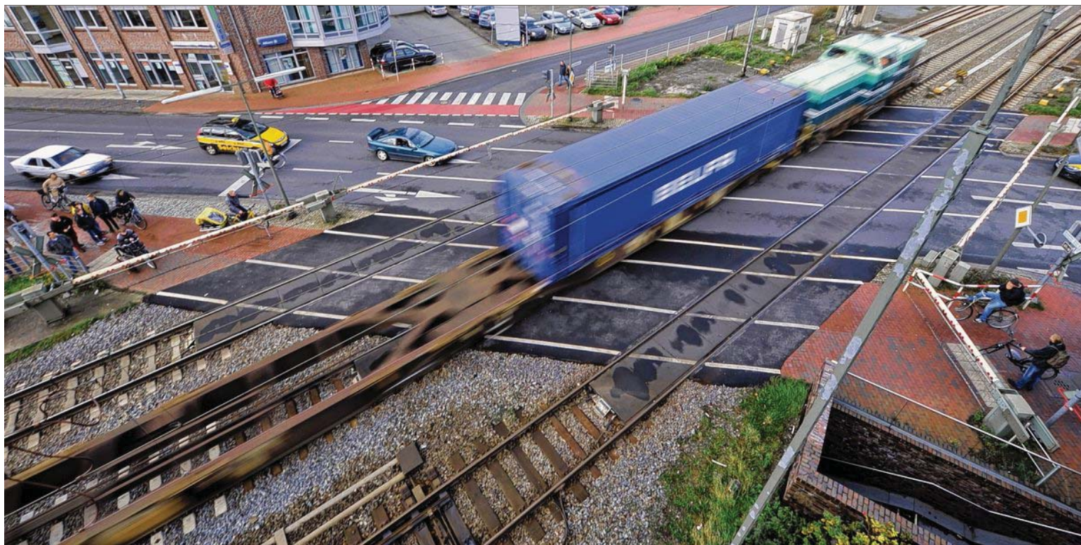
Der Zustand des Fußgängertunnels an der Bremer Straße (unten rechts) soll jetzt noch einmal genau untersucht werden.
