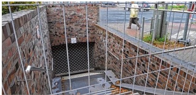
Der gesperrte Fußgängertunnel.
