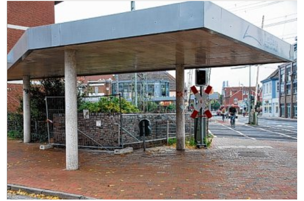
Der Fußgängertunnel ist nach Angaben der Stadt Leer nicht reparabel. BILDER: BEHRENDT
