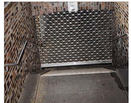
Auch das Rollgitter ist runtergelassen.
