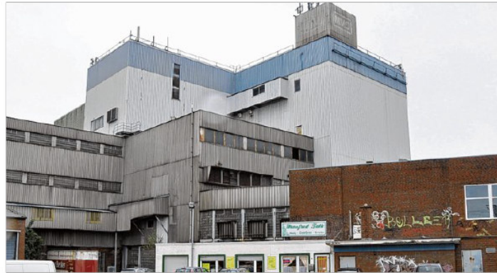
Für die Umgestaltung des Areals muss ein Teil der alten Gebäude weichen. BILDER: WOLTERS
