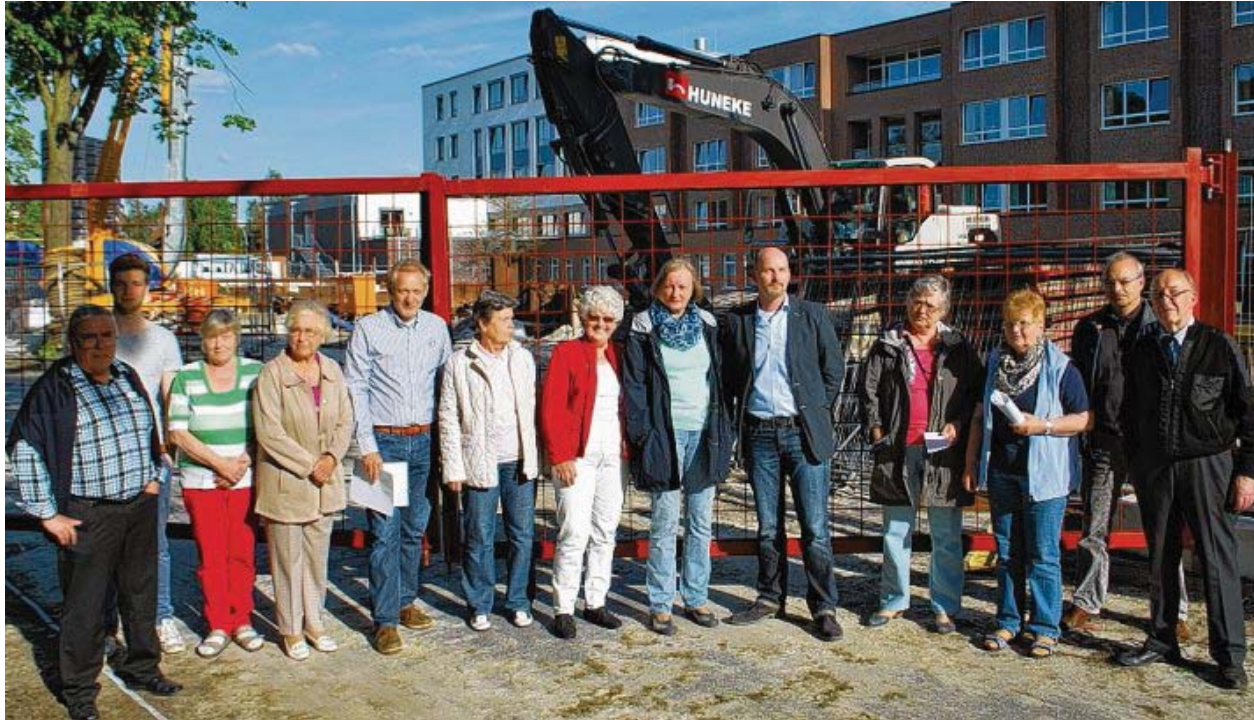
Nachbarn des Klinikums vor der Baustelle. Hier entsteht eine Kinderklinik. BILD: BEHRENDT
