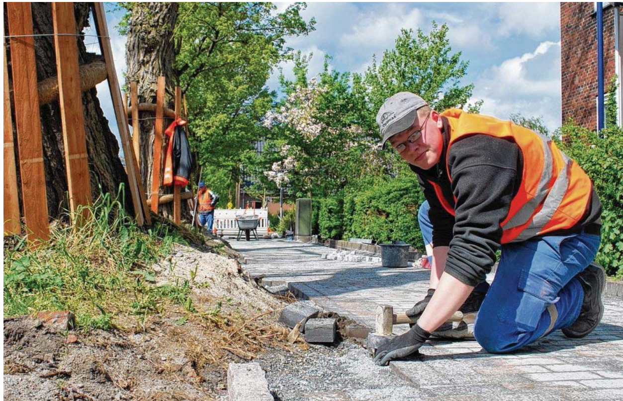
Um die alten Robinien (links) zu schützen, verlegt René Gabels (Firma Schmidt) die Steine für den Gehweg um die Bäume herum.
