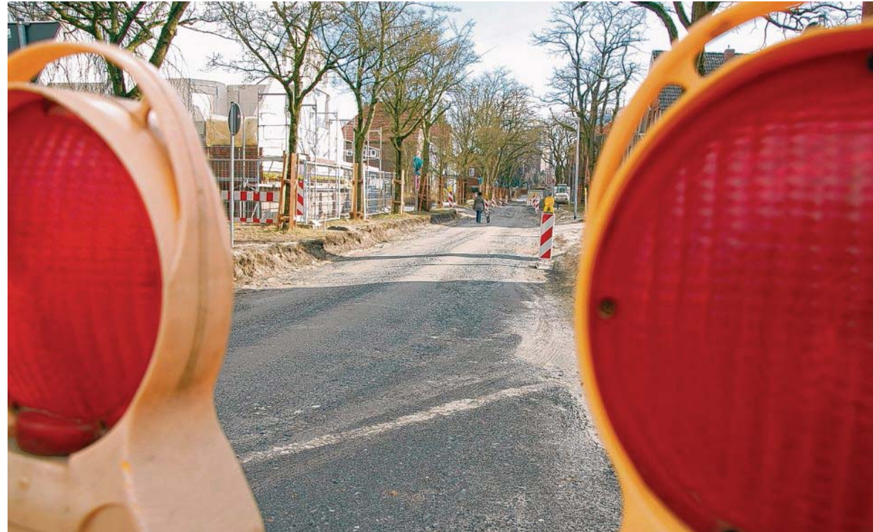
In der Christine-Charlotten-Straße ist bereits die Kanalisation erneuert worden. Jetzt kann mit dem Umbau der Straße begonnen werden.
