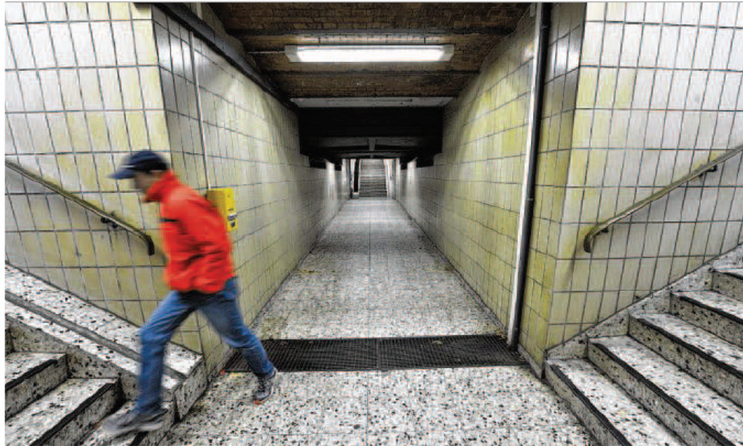
Die Unterführung im Bahnhof soll bis zur Reimersstraße durchgestoßen werden. ARCHIVBILD
