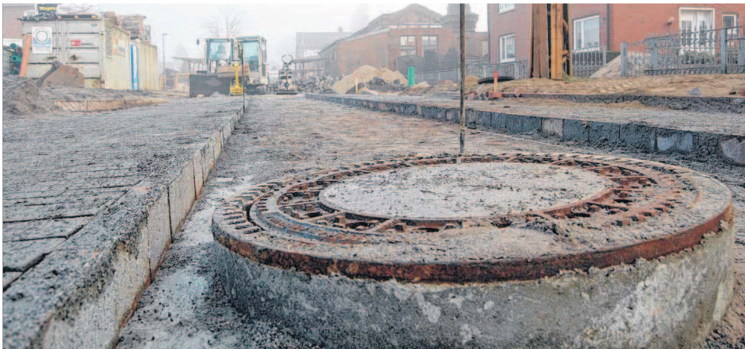
Kanalschacht in der Annenstraße: Links und rechts liegt schon das Pflaster. BILD: KOENEN
