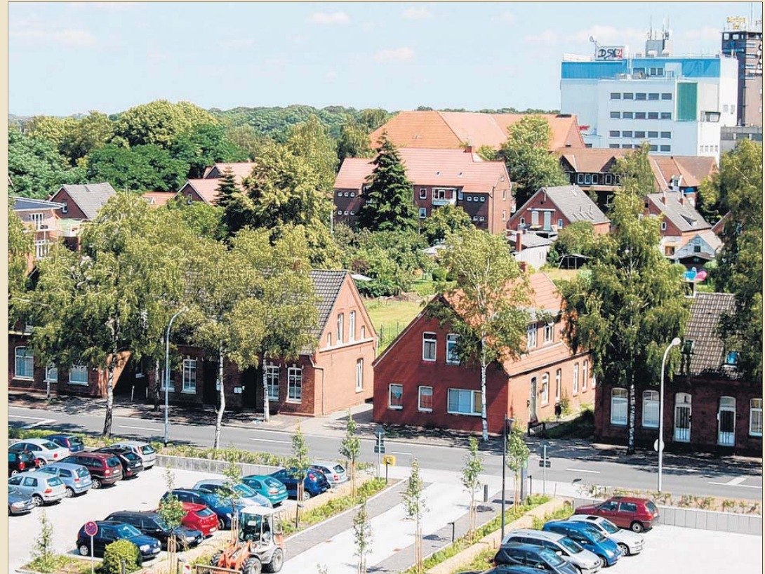
Der Bauverein Leer will vor allem auch für den Erhalt des grünen Innenhofes hinter den Häusern an der Augustenstraße kämpfen.
