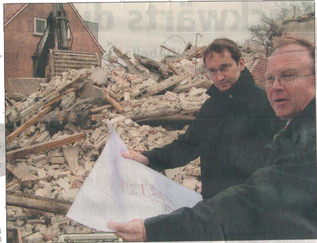
Architekt Thomas Exner und Bauvereinvorstand Fritz Zitterich halten vor dem Schuttberg am Hoheellernweg den Grundriss der neuen Wohnanlage in Händen. Foto: Harald Schirrmann
